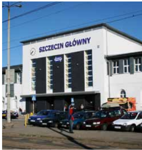
Das Empfangsgebäude des Hauptbahnhofs in Stettin
