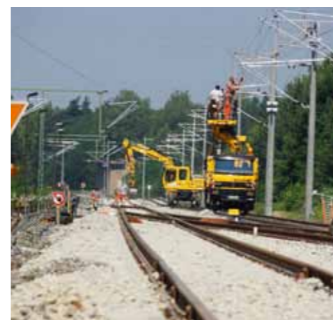
Ausbau der „Niederschlesische Magistrale“
